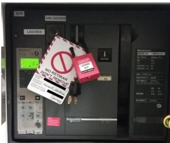
Colocar el candado en la pestaña, junto con la llave extraída y señalización (para modelo MasterPact).
