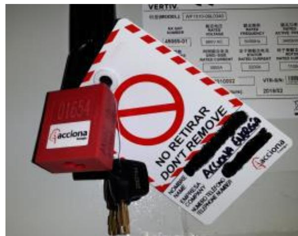
Colocar el candado en la pestana, junto con la llave extraída y señalización (para modelo EasyPact).
